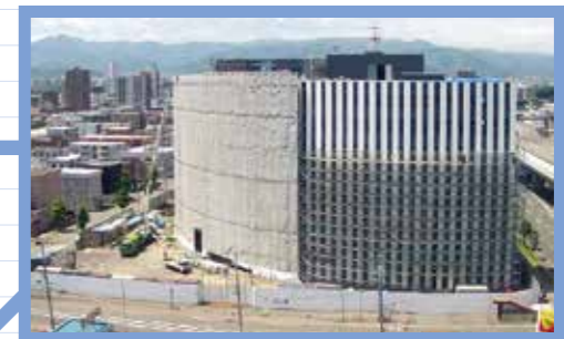
6月6日 入院治療棟東側、工事のための足場の解体が始まりました。
