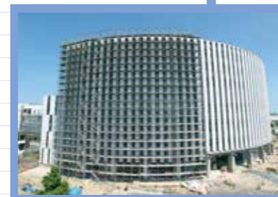
6月18日 入院治療棟(南側)の足場の解体が順調に進んでいます。
